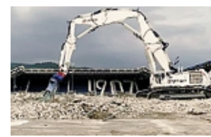
La Curva Sud demolita
