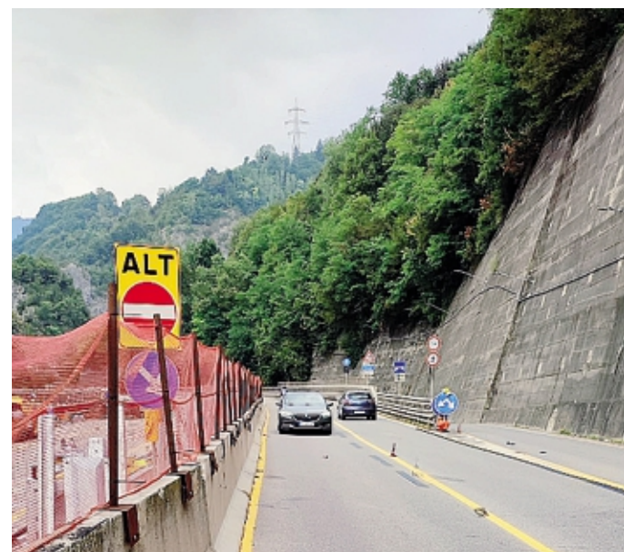
Il tratto di viadotto dove si rischia di toccare i new jersey
